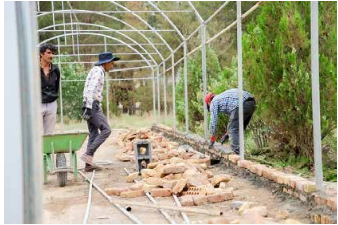
اجرا و راه اندازی سازه گلخانه جدید با متراژ ۱۲۰ مترمربع
